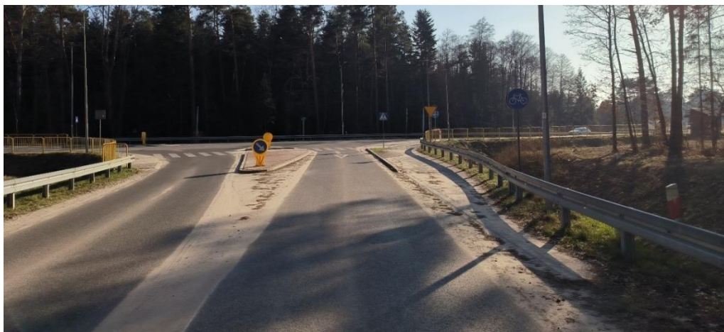
Rysunek 32. Brak ciągłości chodnika między inwestycją a starodrożem – DW764 w gminie Daleszyce.
