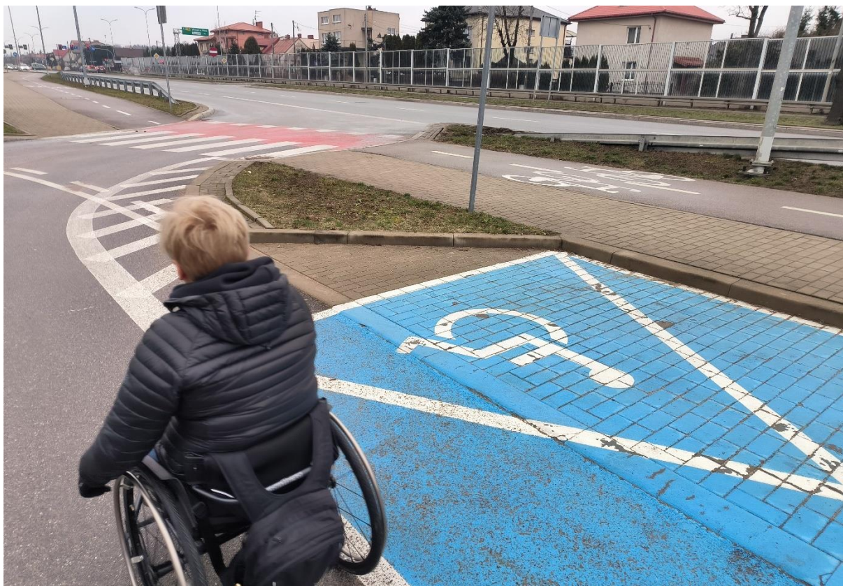
Rysunek 31. Brak obniżenia krawężnika przy miejscu parkingowym dla OzN zmusza do jazdy po ulicy, w celu wjechania na chodnik – Białystok, DW678
