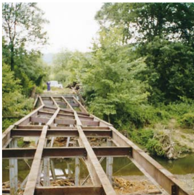
Rekonstrukcja zniszczonej infrastruktury hydrotechnicznej i regulacja potoku w okolicach Karpacza. Fot. arch. PARP
