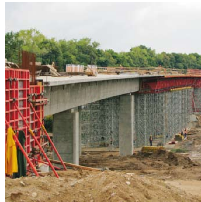
Budowa zachodniej obwodnicy Mrągowa. Fot. arch. PARP
