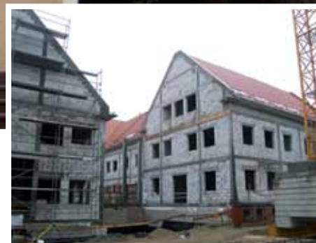
Budowa zespołu laboratoriów dla studentów Wydziału Budownictwa
